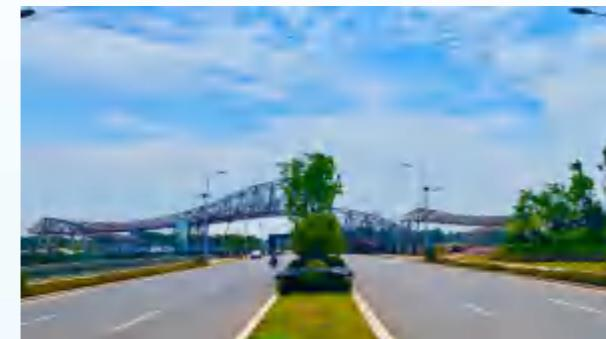
这项工程，即是赣粤产业合作区格力人行天桥钢结构桁架工程。据了解，格力人行天桥、广场及明珠东湖建设工程是赣粤产业合作区项目的子项目之一，其中人行天桥造价约2000万元，结构形式采用空间网格结构，为异形牛头造型，覆盖范围为长225米、宽88.718米、高26米，空间网格结构主要采用钢管和矩形管材料进行焊接和组装成型，总重量为907吨。
